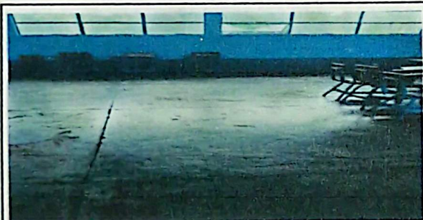
Fotografía 5: Módulo II Piso en mal estado y desnivelado (Cambio de piso a cerámico)
