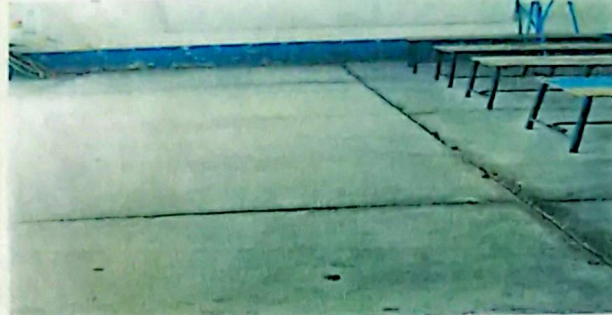
Fotografía 2: Módulo I Piso desnivelado (Cambio de piso a cerámico)
