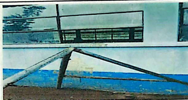
Fotografía 4: Reparación de ventanas. Se sustituirán los vidrios dañados.
