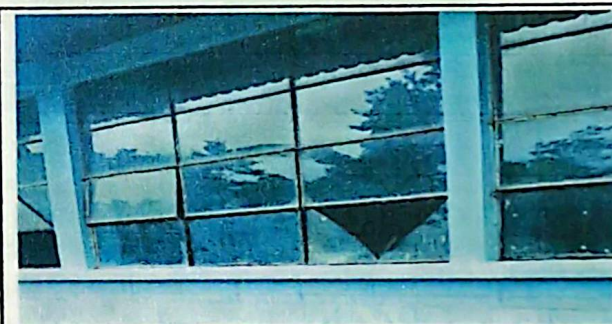
Fotografía 6: Sustitución de vidrios rotos.
